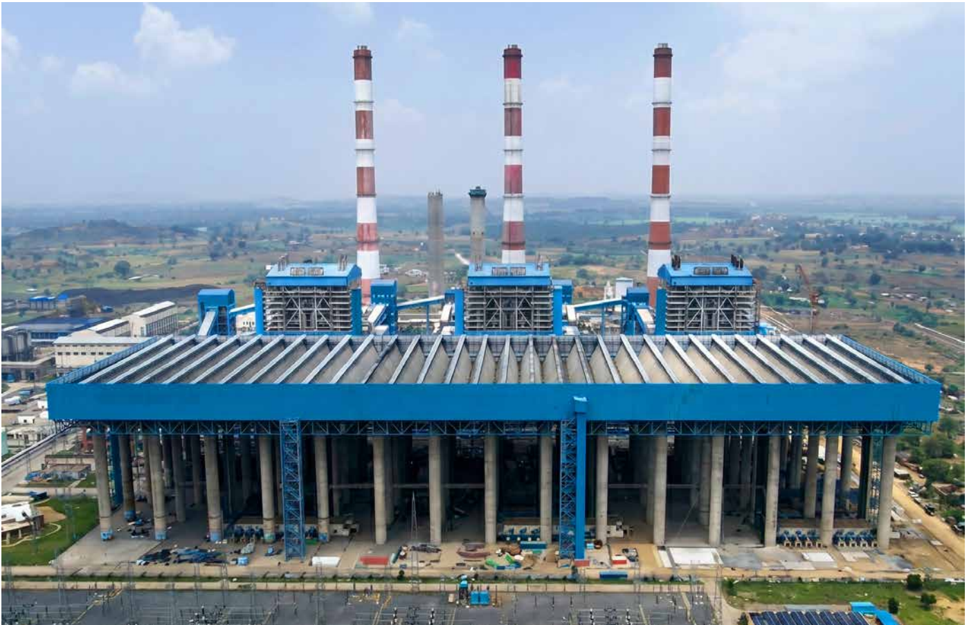
झारखंड में स्थित 3x660 मेगावाट नॉर्थ करनपुरा सुपर थर्मल पावर प्रोजेक्ट बीएचईएल द्वारा कमीशन किया गया। उल्लेखनीय है कि यह डायरेक्ट एयर कूल्ड कंडेनसर से लैस भारत का पहला बड़े पैमाने का सुपरक्रिटिकल थर्मल पावर प्लांट है।
