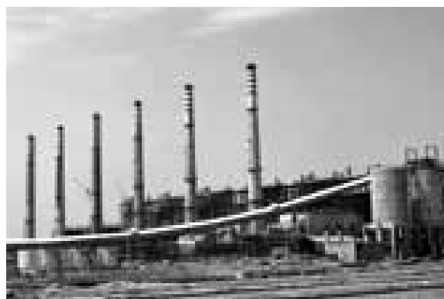
हिंडालको इंडस्ट्रीज लिमिटेड की यूनिट-2 एवं 3 बीएचईएल द्वारा पूर्ण की गई महान एल्यूमिनियम (300 मेगावाट)
