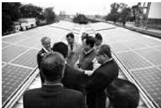
गुडगांव रेलवे स्टेशन में राइट्स के लिए पूर्ण किया गया 25 किलोवाट रूफ-टॉप सोलर पावर प्लांट (प्लेटफार्म शेल्टर का प्रयोग करके)
