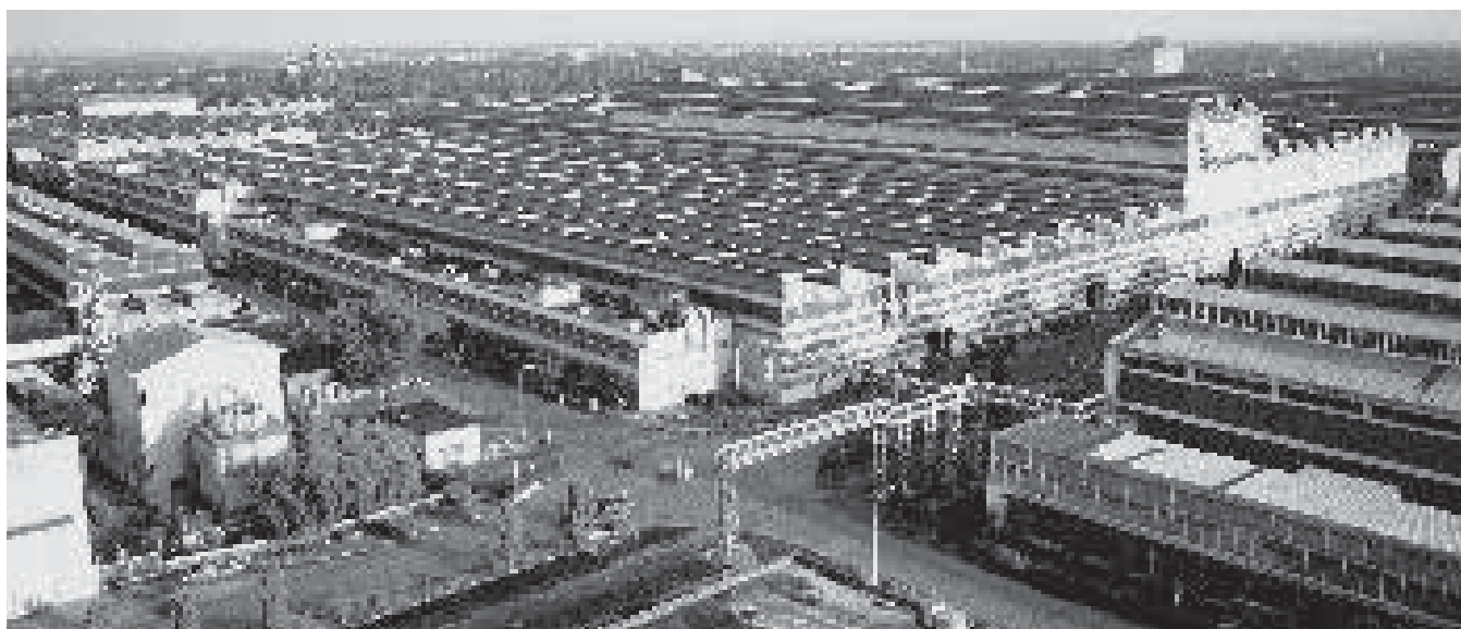
बीएचईएल हेवी इलेक्ट्रिकल प्लांट, भोपाल
